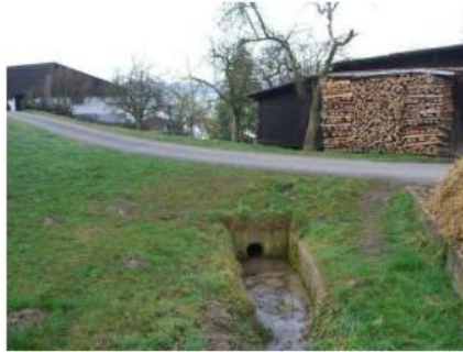
Abbildung 25: Eindolung Kote 523 mit kleinem Absetzbecken
