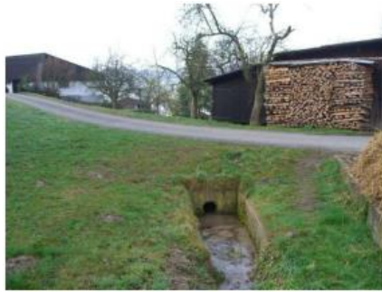
Abbildung 7: Eindolung Kote 523 mit kleinem Absetzbecken
